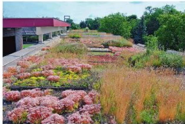
Abbildung 1: Versuchsanlage Dachbegrünung mit 72 Versuchspazellen (Quelle: BOKU Wien, Department für Bautechnik und Naturgefahren, Institut für Ingenieurbauologie und Landschaftsbau).
