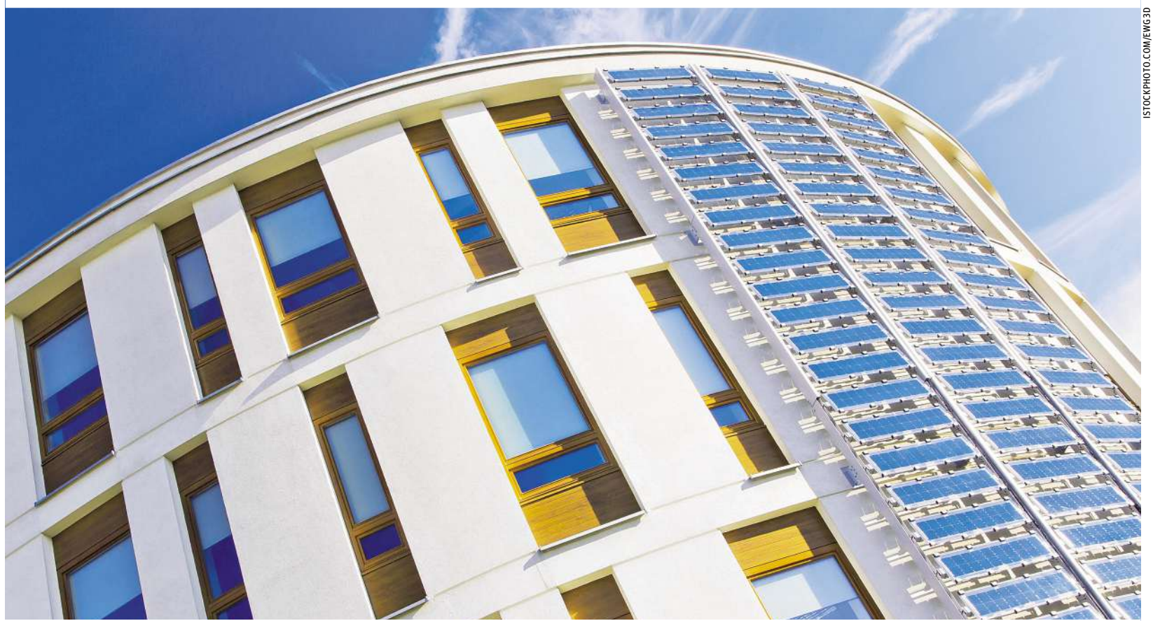
Fassaden der Zukunft sind schon heute Realität: Mit solar-aktiven Energie-Fassadensystemen etwa kann die Sonnenenergie über die Wand genutzt werden
