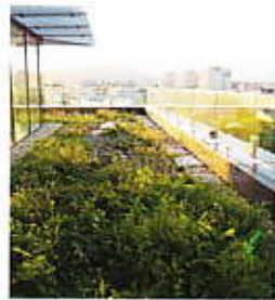
Für kleinere Wartungsarbeiten auf begrünten Dächern sind aufwändige temporäre oder fixe bauliche Absturzsicherungsmaßnahmen laut Normeninterpretation des Bundesministeriums (BMASK) nicht notwendig.
