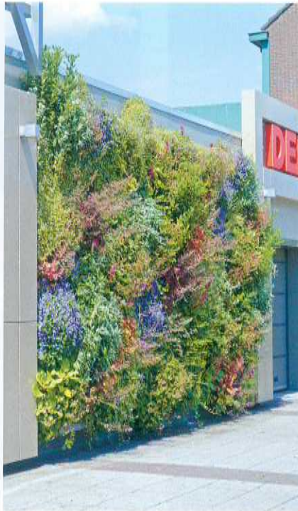
Begrünte Fassaden zeigen je nach Pflanzenauswahl unterschiedliches Brandverhalten.
