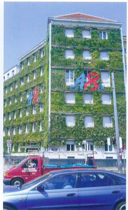
Begrünte Fassaden zeigen je nach Pflanzenauswahl unterschiedliches Brandverhalten.
